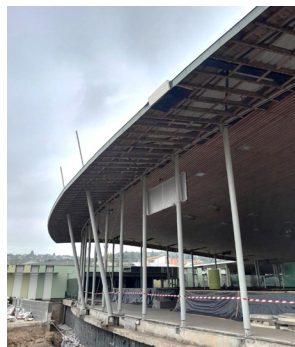
Rénovation énergétique de la piscine communautaire Azergues - juillet 2024 à septembre 2025
