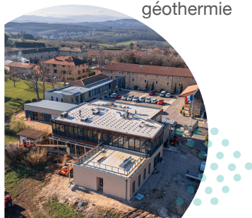
Chantier de l'extension du siège de la CCBPD
