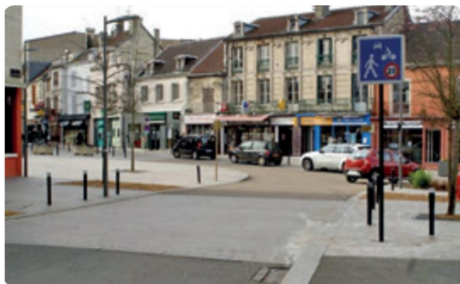
Zone de rencontre et traversée piétonne avec un revêtement contrasté adapté aux malvoyants – CEREMA Rues apaisées
