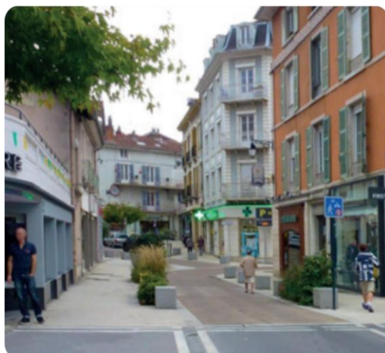
Zone de rencontre aménagée avec végétation et blocs pour réduire la bande ouverte aux véhicules – CEREMA Rues apaisées
